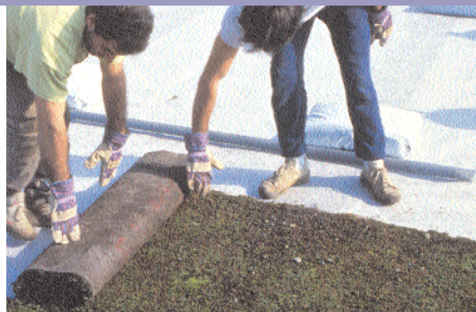
Mise en œuvre de rouleaux précultivés
